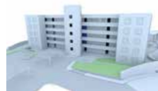
TORRE 1 • VISTA AL ESTACIONAMIENTO
