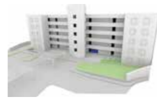
TORRE 1 • VISTA AL ESTACIONAMIENTO
