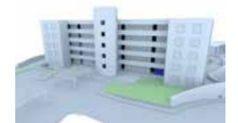
TORRE 1 • VISTA AL ESTACIONAMIENTO
